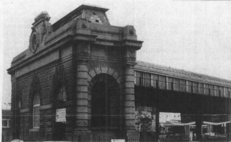
1993 - Dover Western Docks, het ingangsgebouw van de Marine Station aan de Lord Warden Square, met rechts de overdekte spoorovergang
