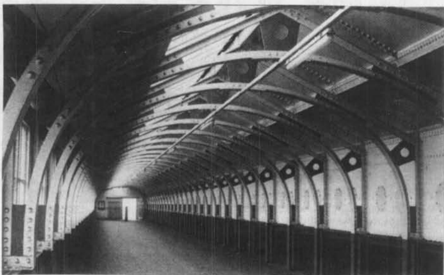
1993 - Dover Western Docks, Marine Station, de verlaten en desolate lange spoorovergang leidend naar de sporperrons en inschepingshal.
