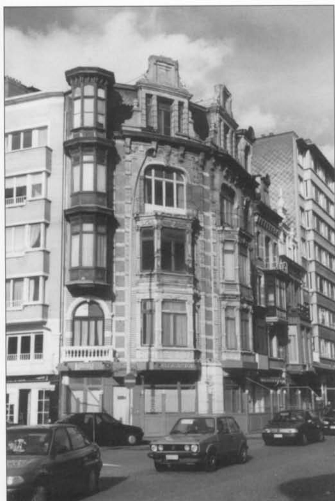
Voor de restauratie Foto's: Wille - Joosten.
