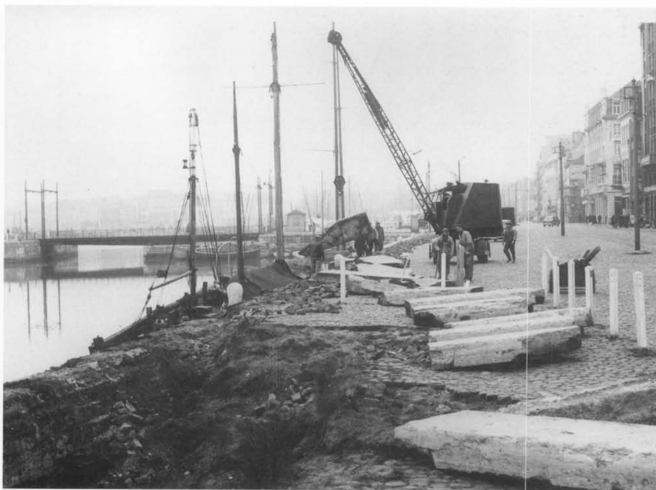
Werken aan de kaaimuren van de eerste "bassing" Let op het Hotel Stella Maris en het Hôtel de la Couronne
