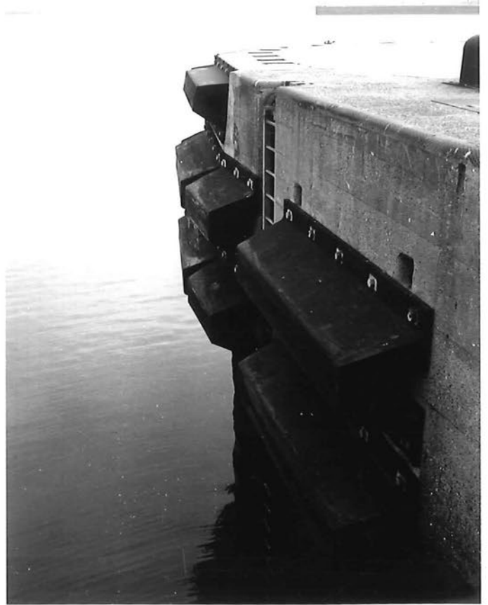
40. Charles de Gaullesluis: sluishoek zeezijde - zuidkant
