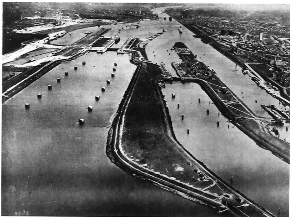
47. IJmuiden. Noordersluis: buitentoeleidingskanaal (1938)
