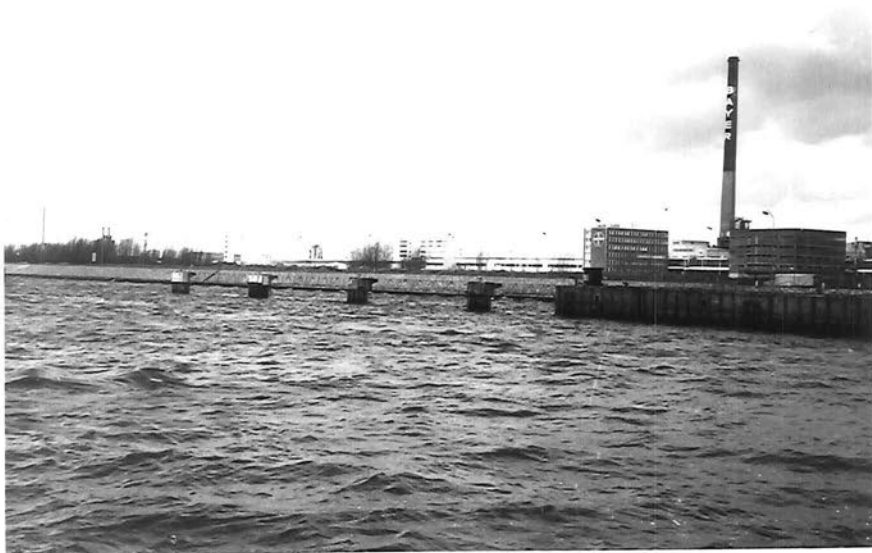
7. Boudewijnsluuis: sluisoegang Scheldezijde - noordkant
