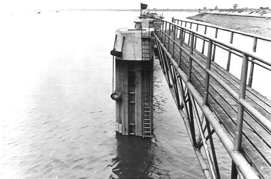
8. Boudewijnsluuis: sluisoegang Scheldezijde - noordkant (1964)
