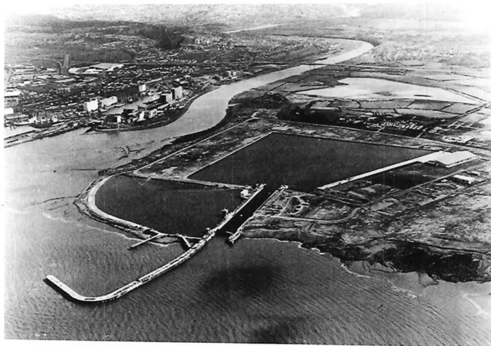
62. Bristol: sluis en pier
