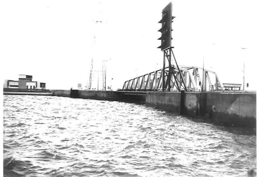
22. Kallosluis: sluistoegang dokzijde
