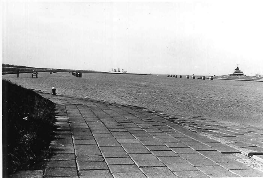
53. Terneuzen. Westsluis: buitentoeleidingskanaal
