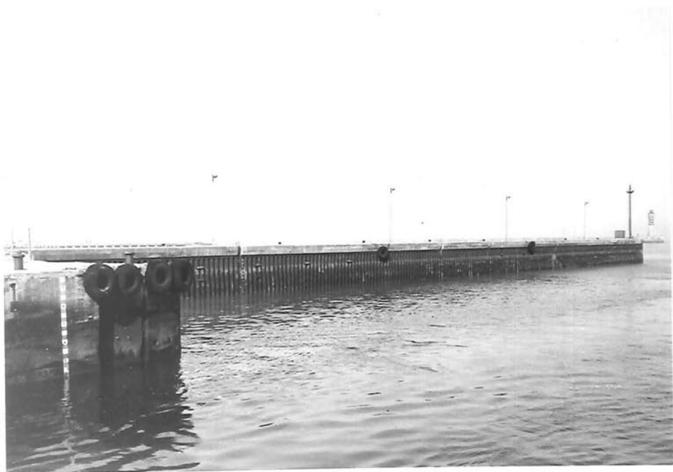
28. Watiersluis: zee kant met pier en sluishoek
