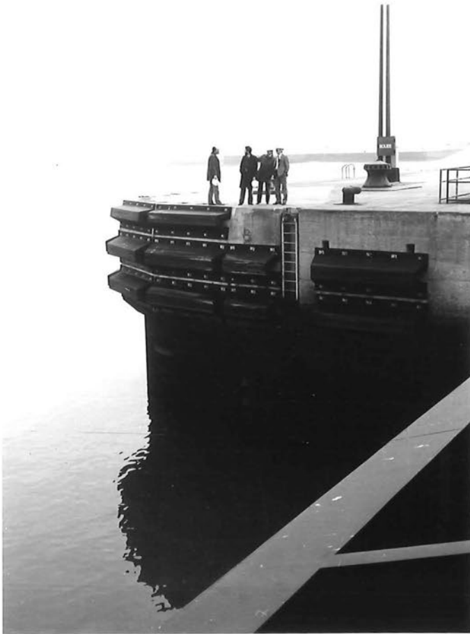
39. Charles de Gaullesluis: sluishoek zeezijde - zuidkant
