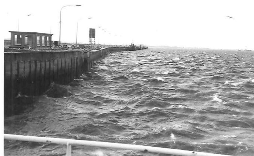
14. Zandvlietslus: toegangseul Scheldezijde - zuidkant
