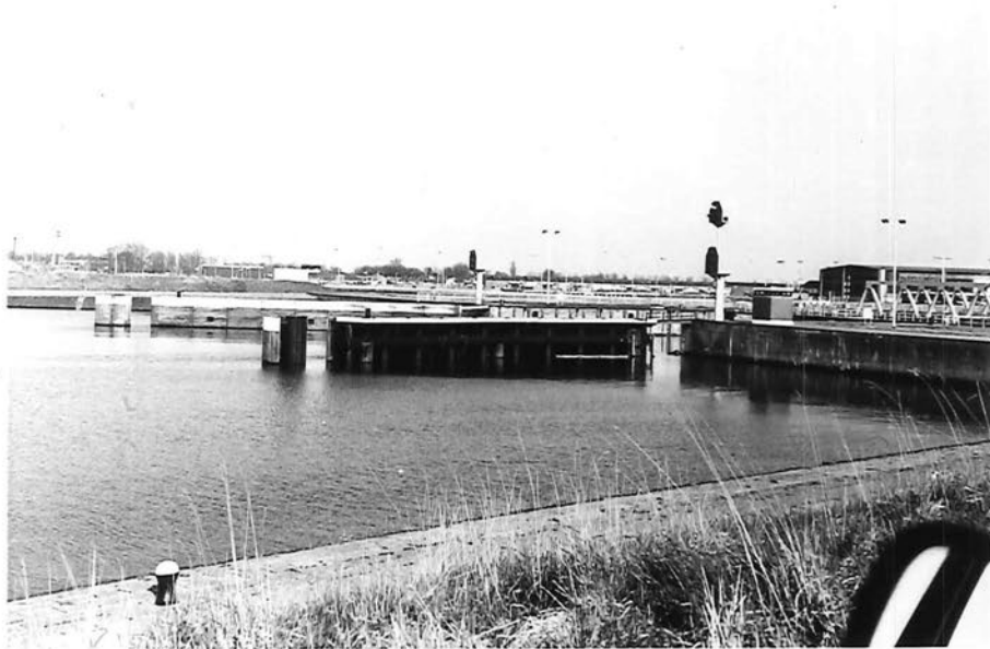
54. Terneuzen. Westsluis: toegang Scheldezijde met geleidewerken
