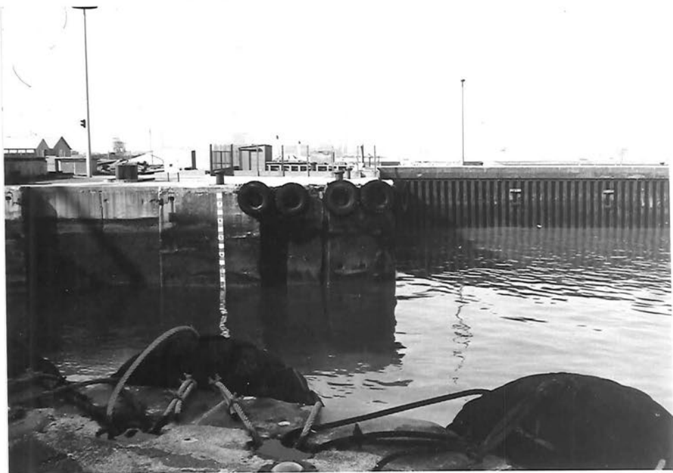
29. Watiersluis: zee kant met pier en sluishoek
