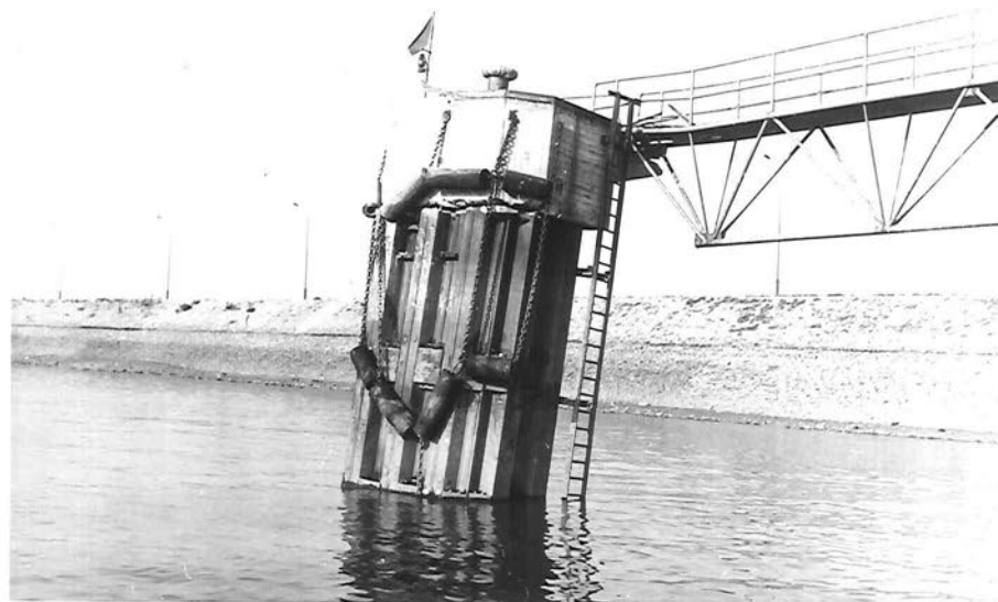
10. Boudewijnsluuis: sluisoegang Scheldezijde - noordkant (1959)
