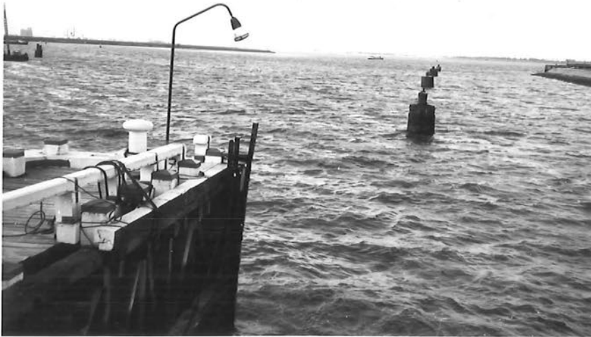
2. Van Cauwelaertsluis: toegangsegeul Scheldezijde - noordkant
