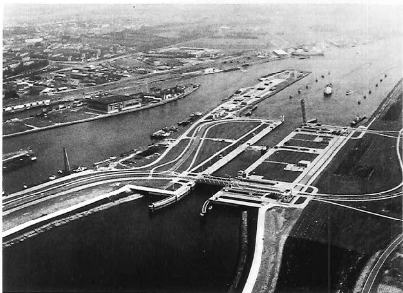
52. Terneuzen. Westsluis: overzicht
