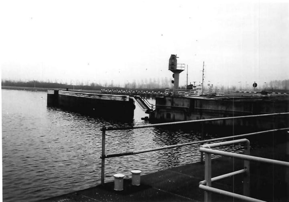
56. Terneuzen. Westsluis: toegang kanaalzijde met geleidewerk west
