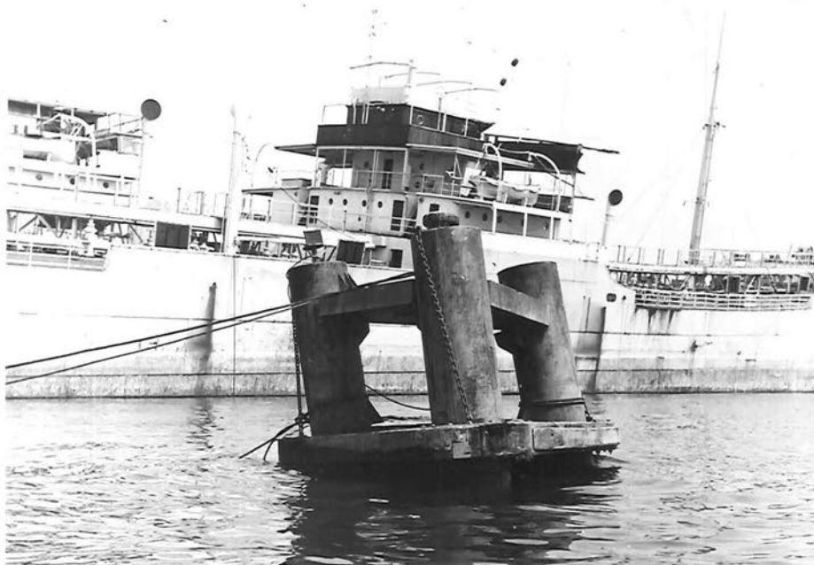
12. Boudewijnslus: sluistoegang dokzijde (1959)
