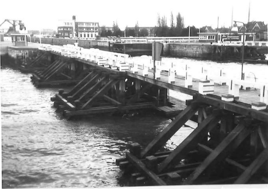
4. Van Cauwelaertsluis: geleidewerk Scheldezijde
