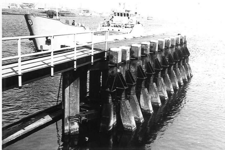
51. IJmuiden. Noordersluis: binnentoeleidingskanaal en geleidewerk zuid
