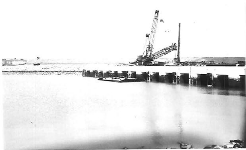
23. Zeesluis Zeebrugge: toegangseul zeezijde - oostkant (1980)
