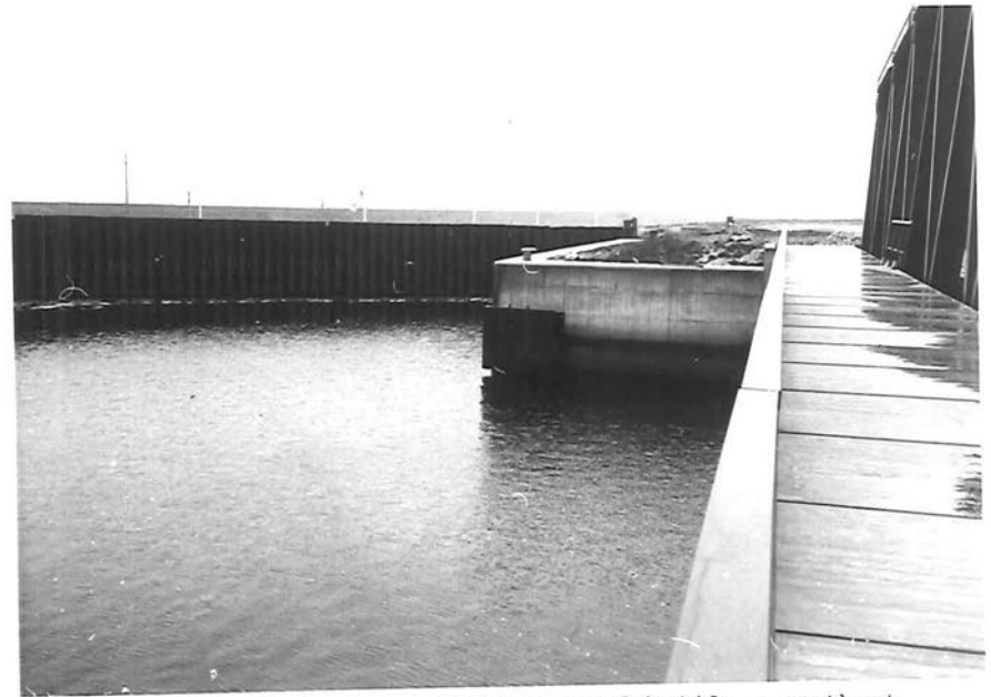
25. Zeesluis Zeebrugge: sluisoegang dokzijde - westkant
