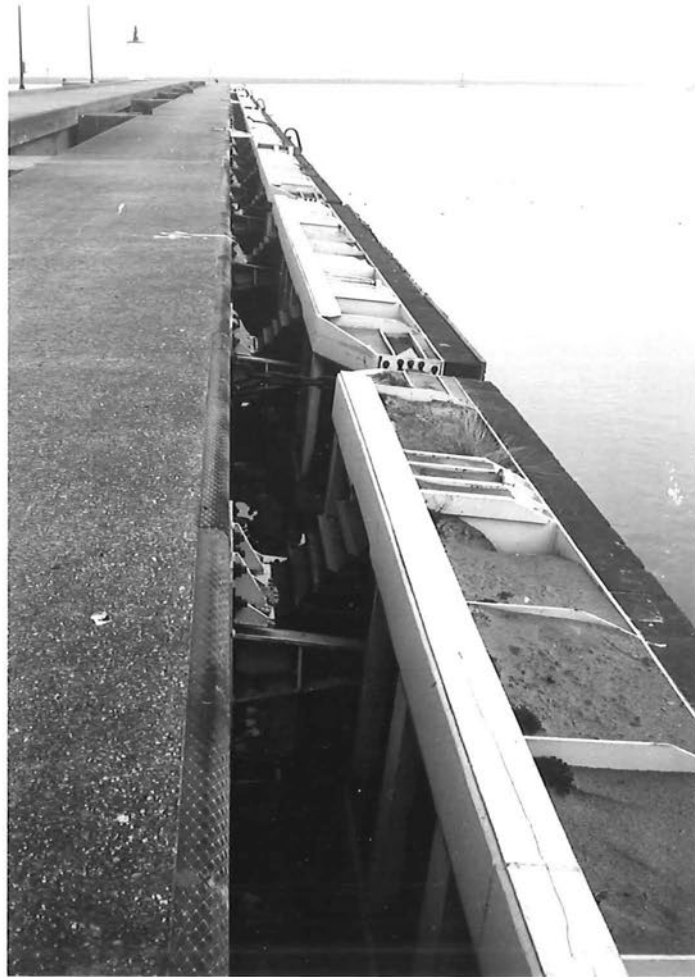
34. Charles de Gaullesluis: pier aan zeezijde: fenders
