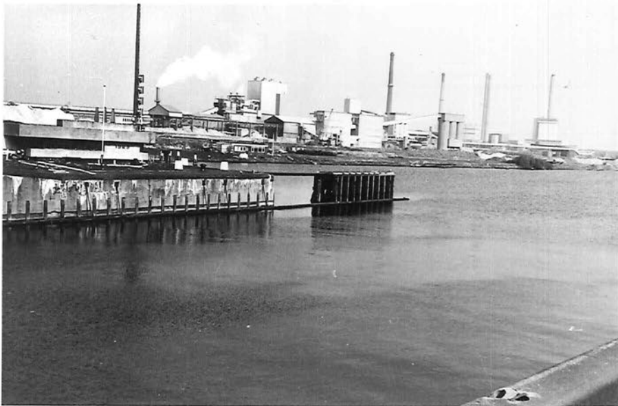
50. IJmuiden. Noordersluis: opwaarts sluishoofd en geleidewerk noord
