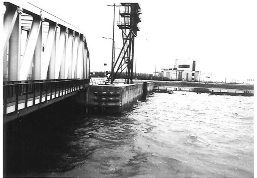
21. Kallosluis: sluistoegang dokzijde - zuidkant
