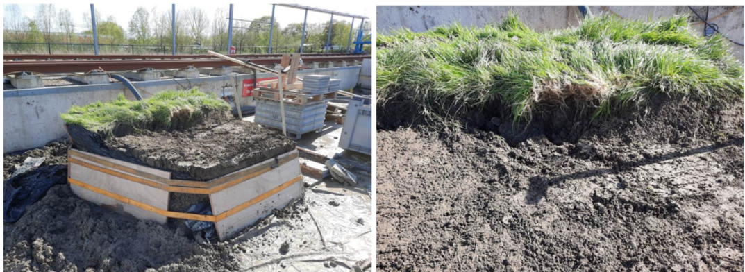
Figuur 16. Impressie van de testopstelling van Test 3 alvorens te testen
