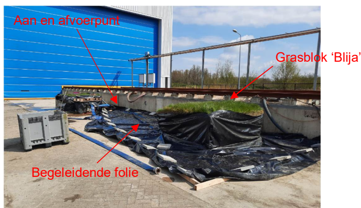
Figuur 5. Overzicht proefopstelling in aanbouw (brandslang is nog niet aangebracht)
