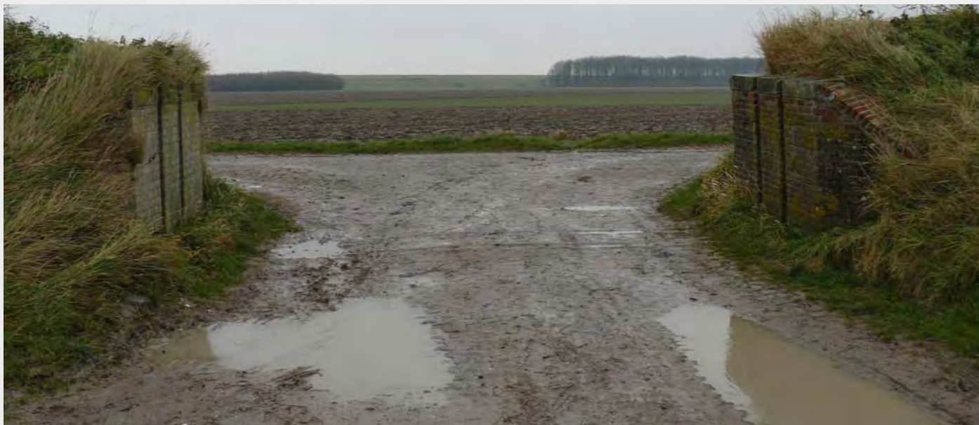
Figuur: 10. De Willem-Leopoldpolder: zicht naar hetnoorden met aan de horizon de Internationale Dijk en het oostelijk en het westelijke bosje in de polder. Aan de voorkant één van de doorsteken in de Hazegraspolderdijk die afgesloten kunnen worden. Foto: Technum-Tractebel Engineering © 2008.
