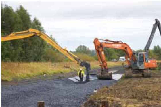
Afbeelding 712. Aanleg dissipatiegracht met open steenasfalt
