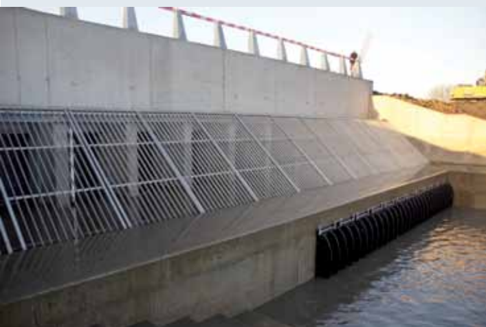
Afbeelding 7.10. Installatie van de randinfrastructuur
