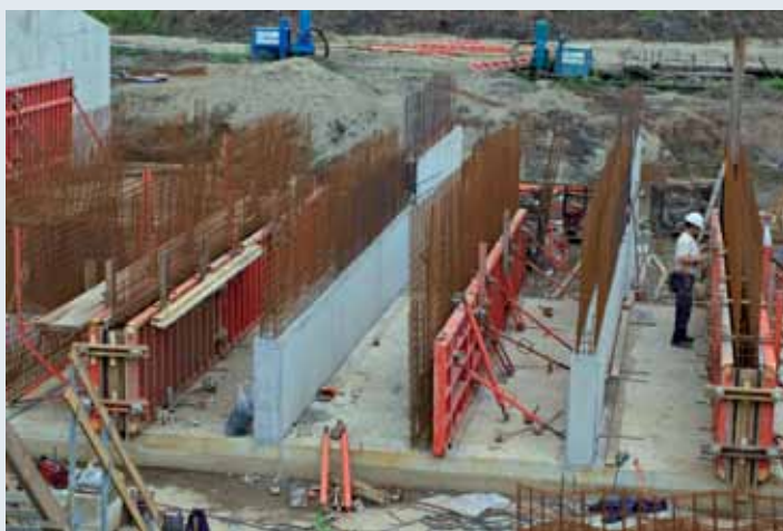
Afbeelding 7.7. Betonnering van de wanden
