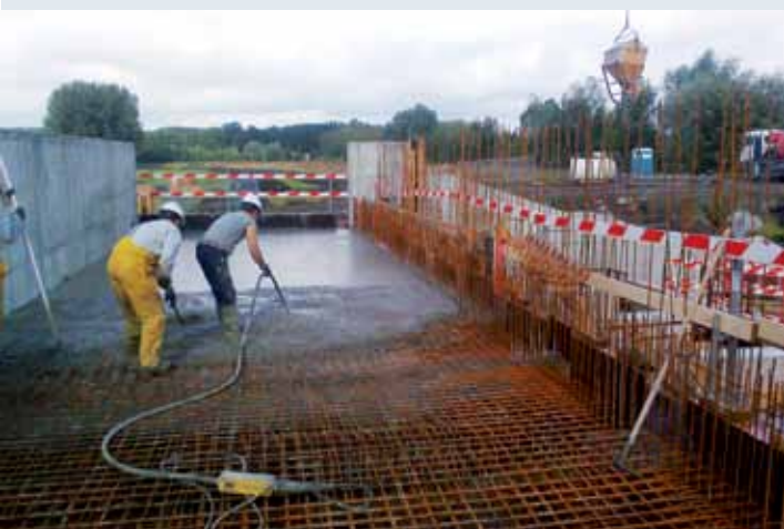
Afbeelding 7.6. Vloerplaat en damplanken tegen onderloopsheid
