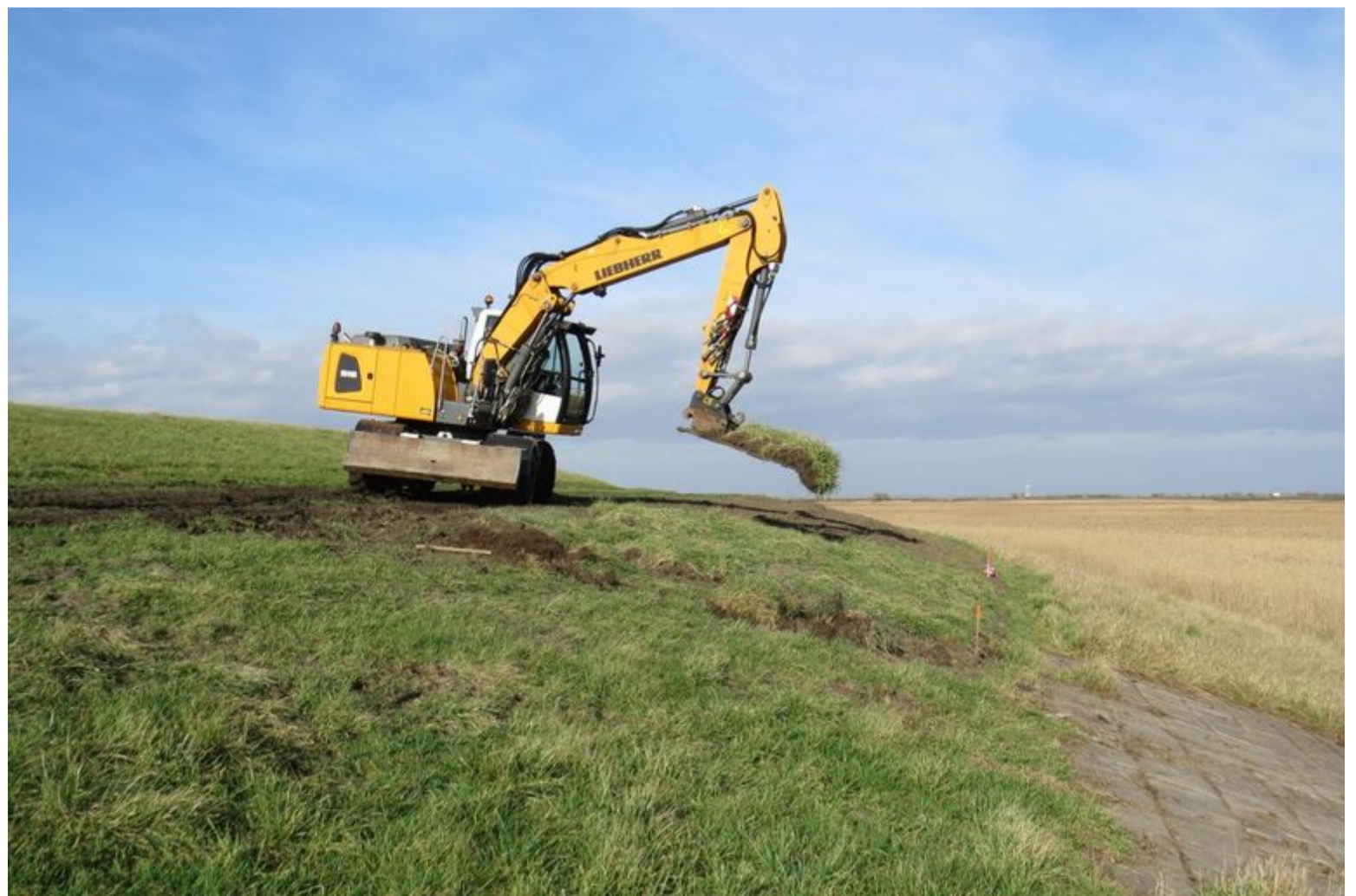
Transplantatie van zoden naar een proefvak. Onderaan de dijk zijn grijze stenen zichtbaar, overgroeid met gras. Voor de dijk een voorland met (bruine) rietplanten (Bron: Kim van den Hoven)
