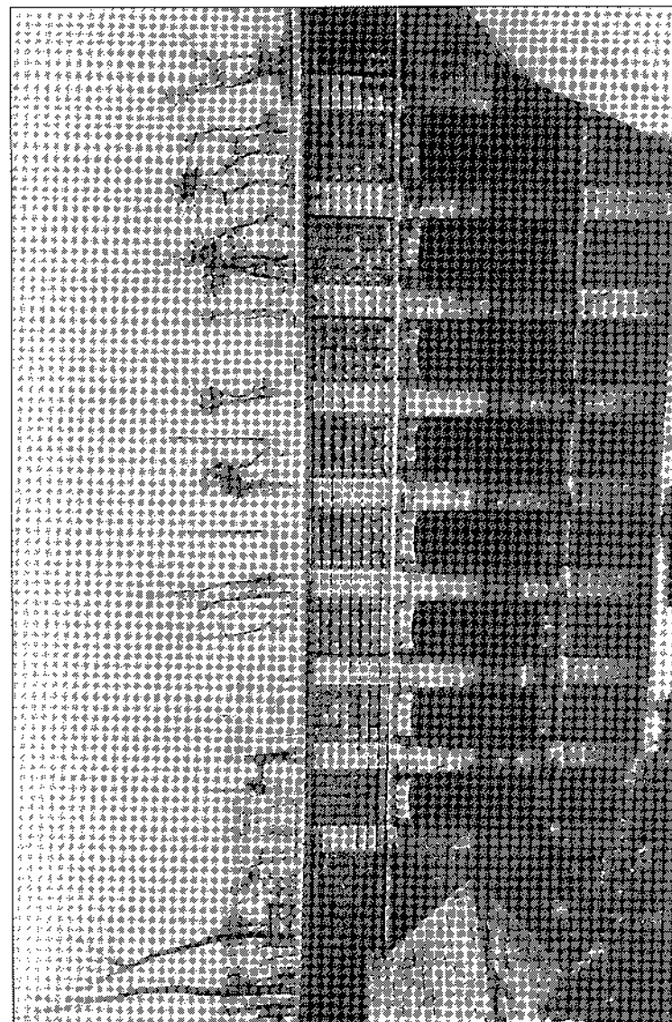
De overlaat van de Noordvaart in 1914. Bemerkt de twee personen links die een schuif manteel bedienen.
