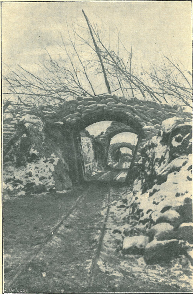
CAESKERKE. — Gang met gewelfpoorten en Decauville-spoor (1916).
