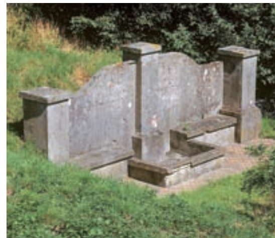
■ De 'Barbara Brunnen', verwijzend naar de beschermheilige van de artilleristen, was één van de drie waterpunten van de batterij Aachen tijdens de Eerste Wereldoorlog. De naam was toen in grote letters aangebracht op het monument. Het maakt nu deel uit van het openluchtmuseum Atlantikwall (Raversijde) (Jeroen Cornilly, Provincie West-Vlaanderen)
