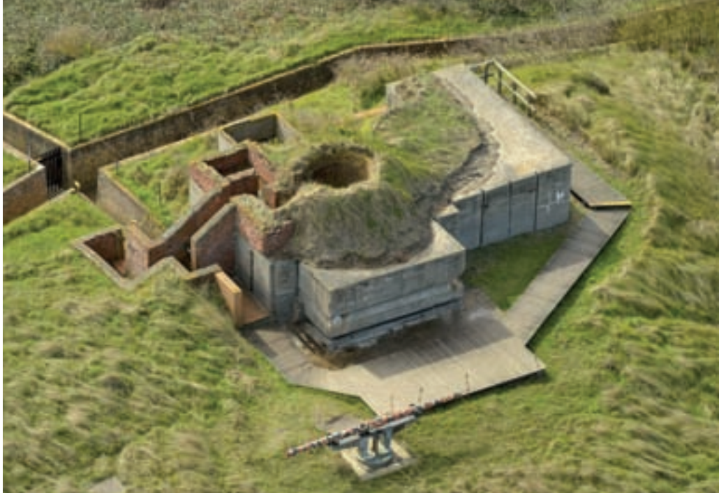
■ De observatie- en commandobunker van batterij Aachen, met daarnaast de telemeter, die zich zeker tijdens een deel van de oorlog op het dak van deze bunker bevond. Het maakt nu deel uit van het openluchtmuseum Atlantikwall (Raversijde). De bakstenen constructies werden door de Duitsers gebouwd tijdens de Tweede Wereldoorlog, toen enkele bunkers van de batterij geïncorporeerd werden in de Atlantikwall (Yves Adams, Provincie West-Vlaanderen)
