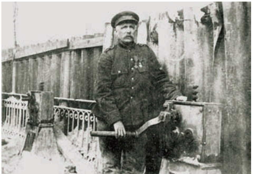
■ Hendrik Geeraert poseert bij één van de tandwielkasten aan de overlaat van de Noordvaart (Collectie Callanaere-Dehouc)
