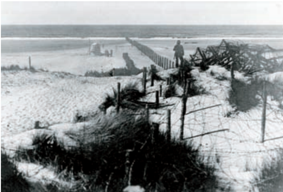
■ „Der elektrische Draht“ auf der Grenze zwischen Belgien und den Niederlanden. Auf diesem Foto des Strandes von Knokke ist zu sehen, dass der „Draht“ sogar bis zum Wasser verlief. Im Laufe des Krieges wurde der Zaun erhöht und erweitert. Er war anfangs ungefähr 1,50 m hoch und wurde später auf rund 2,50 m erhöht. Rund 500 Menschen überlebten eine Berührung des Drahtes nicht. (Sammlung Erwin Mahieu)
