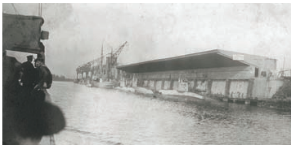
■ Un torpilleur navigue le long de quelques sous-marins de classe UB-I amarrés dans l'arrière-port de Bruges. Des appentis construits en béton et en bois leur offraient une protection contre les attaques aériennes potentielles (Tomas Termote)
