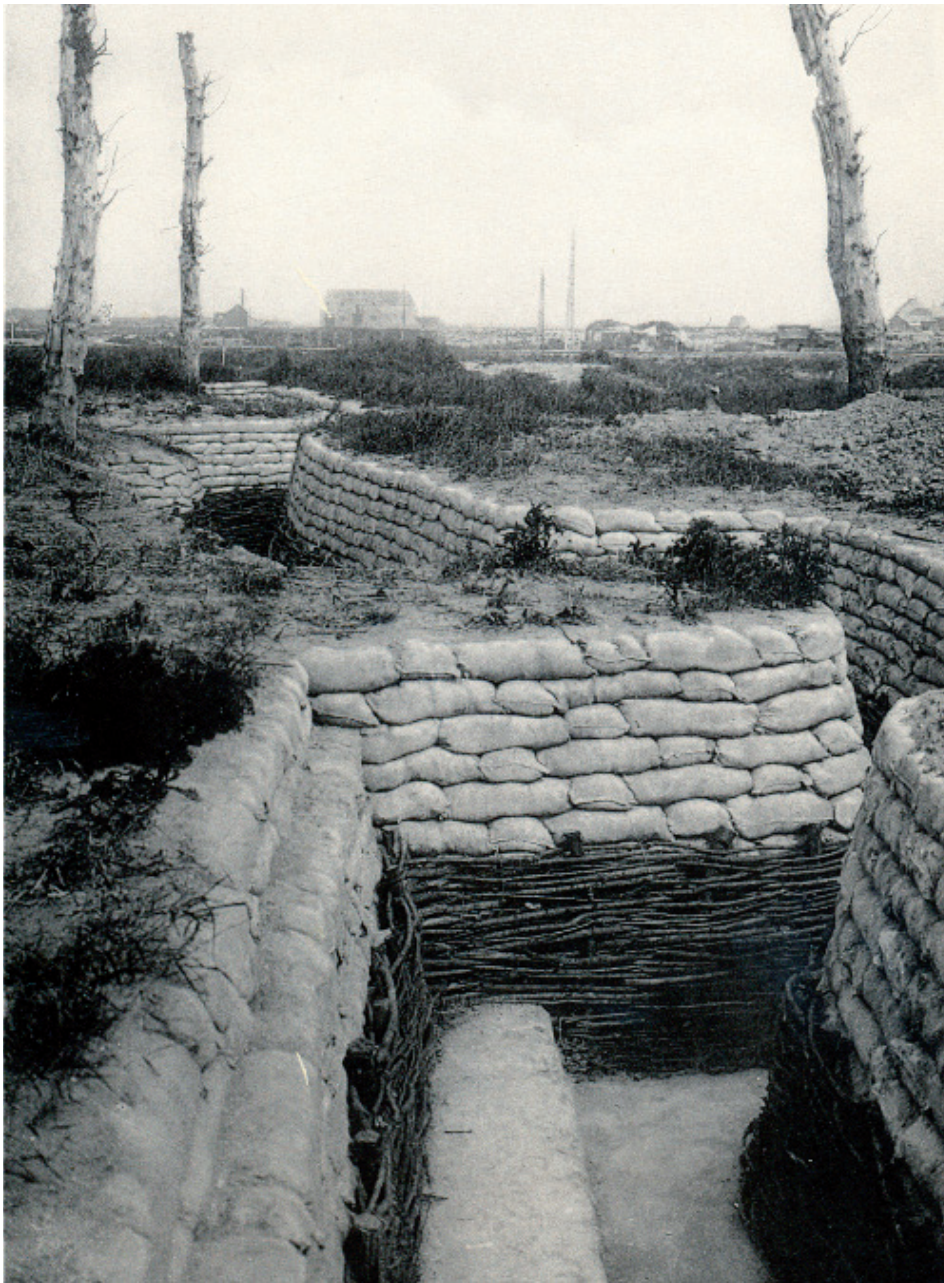
■ La version « restaurée » du Redan de Nieuport. Il ne reste rien des vestiges d'origine (Collection privée)
