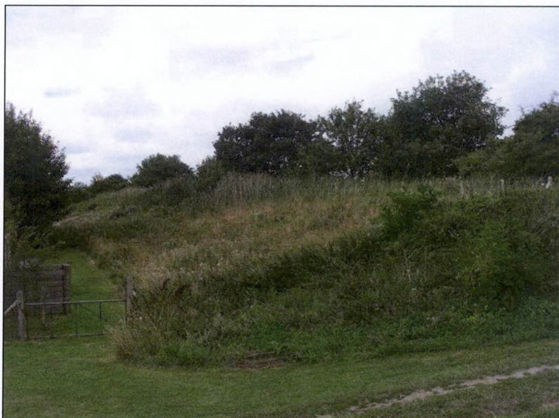
Figuur 42: De oostelijke dijk van de Nieuwe Hazegraspolder ter hoogte van het 'Zwarte Huis', of de kruising van Corridor A en C, en Stapsteen B. De ruigte bestaande uit struweel en kruiden is ideaal als corridor.
