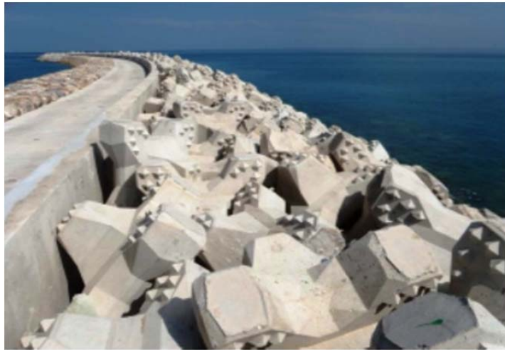
Figuur 15: Afbeelding Accropod
