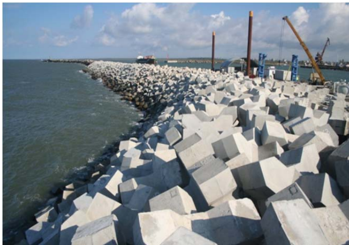
Figuur 14: Afbeelding XBlock
