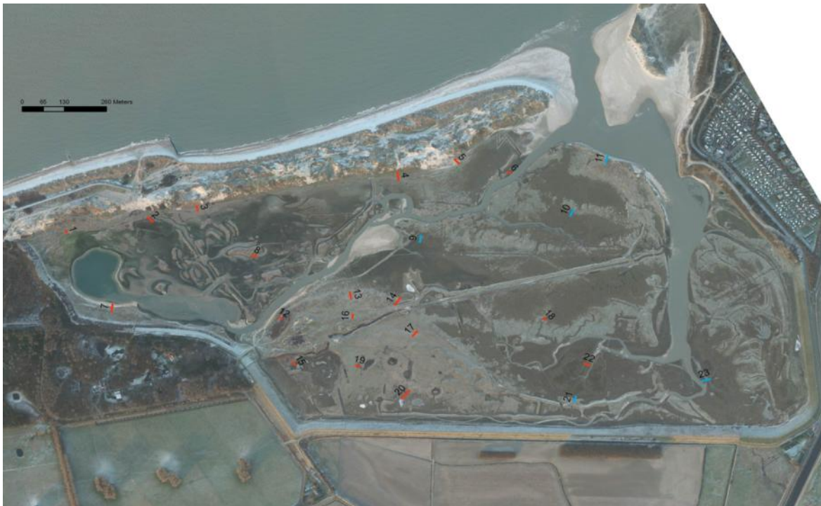
Figuur 3.4. Ligging van de transecten die gebruikt zijn voor het vegetatieonderzoek ten behoeve van het beheerplan. Een selectie ervan werd voor het ZTAR- monitoringsonderzoek gebruikt om de ontwikkelingen in de vegetatie ten gevolge van de toegepaste beheer maatregelen te kunnen vaststellen. Bij een aantal van de transecten werden naderhand ook bodemvallen geplaatst (zie partim fauna)
