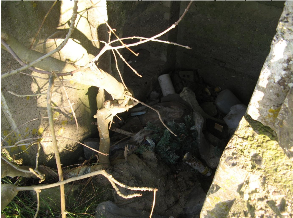
Foto. Het verwijderen van alle mogelijk afval uit bunkers is een van de vaakst te nemen maatregelen bij de inrichting van dit oorlogserfgoed als vleermuizenverblijfplaats (bunker Nieuwe Hazegraspolderdijk-Knokke).
