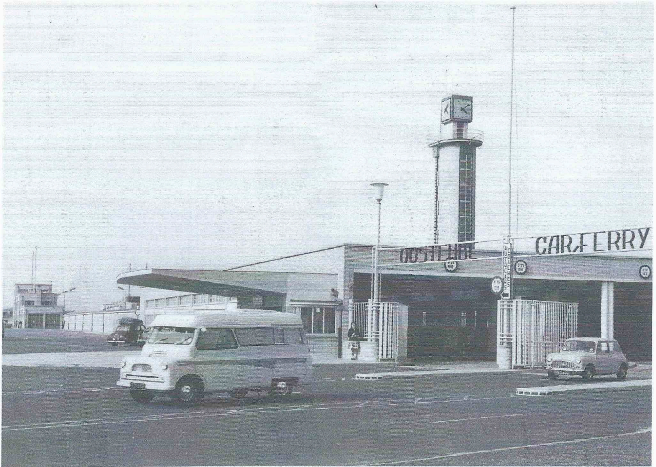
Fig. nr. 217. Haven Oostende, 1960. De toegang tot het carferrygebouw
