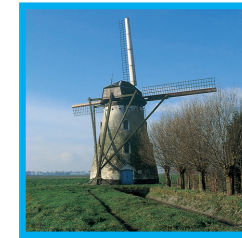
› De Sint-Karelsmolen, een vijzelmolen ingezet voor de bemaling van de Moeren.
