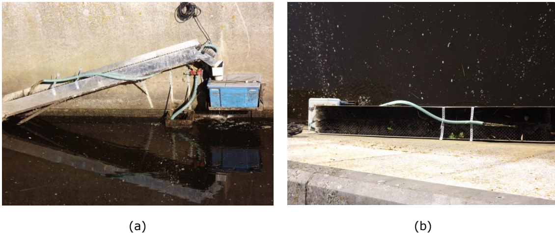
Fig. 25. Zijaanzicht (a) en bovenaanzicht (b) van het bovendeele en de opvangbak van de aalgoot.
