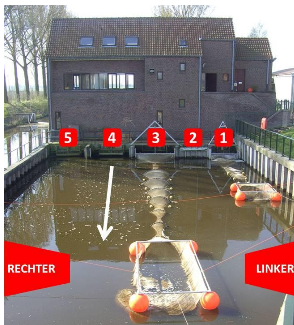
Fig. 19. De verschillende pompen van het Isabellagemaal. Pompen 1 en 2 zijn kleine vijzels, de andere 3 pompen zijn grote vijzels. Pompen 1 en 3 worden bemonsterd mbv. fuiken en een Noors leefnet (vierkante vangstconstructie tussen de vier oranje boeien). De witte pijl duidt de stroomrichting aan; RECHTER = rechteroever; LINKER = linkeroever.
