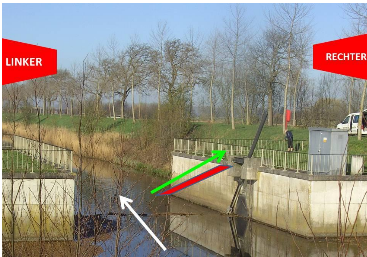
Fig. 24. Locatie van de aalgoot ter hoogte van de stuw te Sint-Laureins. De stroomopwaarts migrerende paling volgen de groene pijl. De witte pijl duidt de stroomrichting aan; RECHTER = rechtereover; LINKER = linkeroever.
