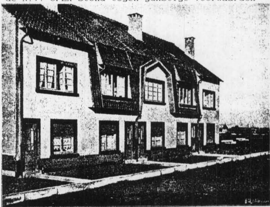
Groupe d'habitations construites par la Société Opex.
