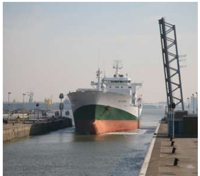
De noordbrug van de westsluis wordt begin 2008 vervangen
