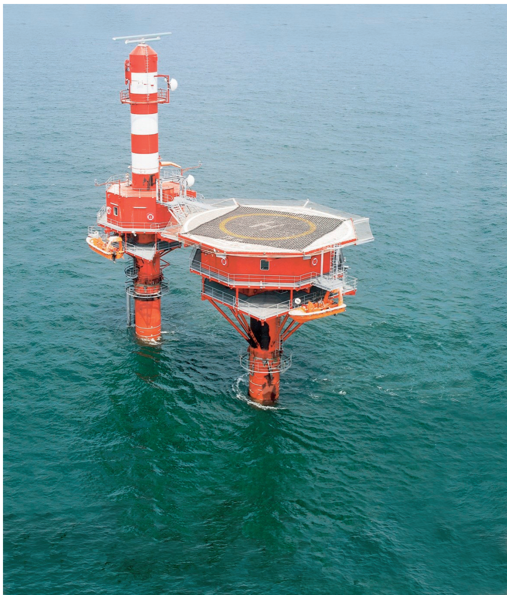
Radartoren Oostdyckbank (ter hoogte van Oostende), vanaf 2003 operationeel.
