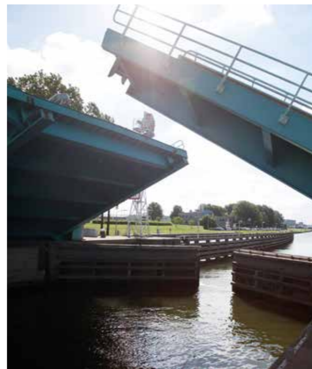
Jaarlijks passeren circa 10.000 zeeschepen, ruim 50.000 binnenvaartschepen en circa 3.000 pleziervaartuigen het sluisencomplex in Terneuzen.
