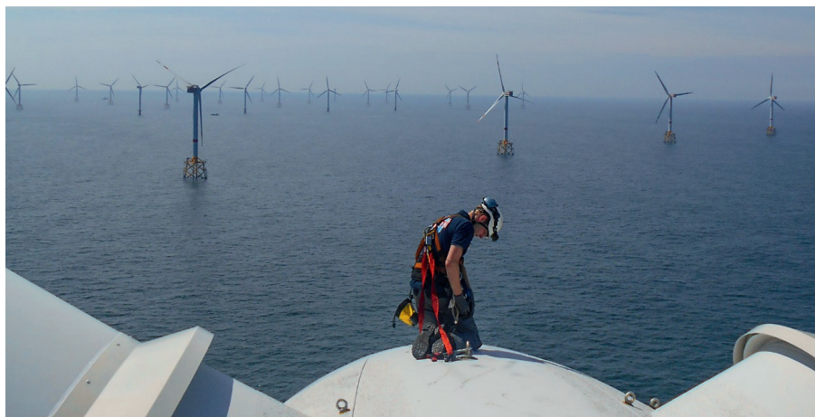
Gedurende gemiddeld 85% van het jaar draaien windturbines effectief en produceren ze dus stroom. Onder andere tijdens het onderhoud, zoals hier bij de inspectie van de wieken door een techniker, liggen de turbines stil. ©C-Power
