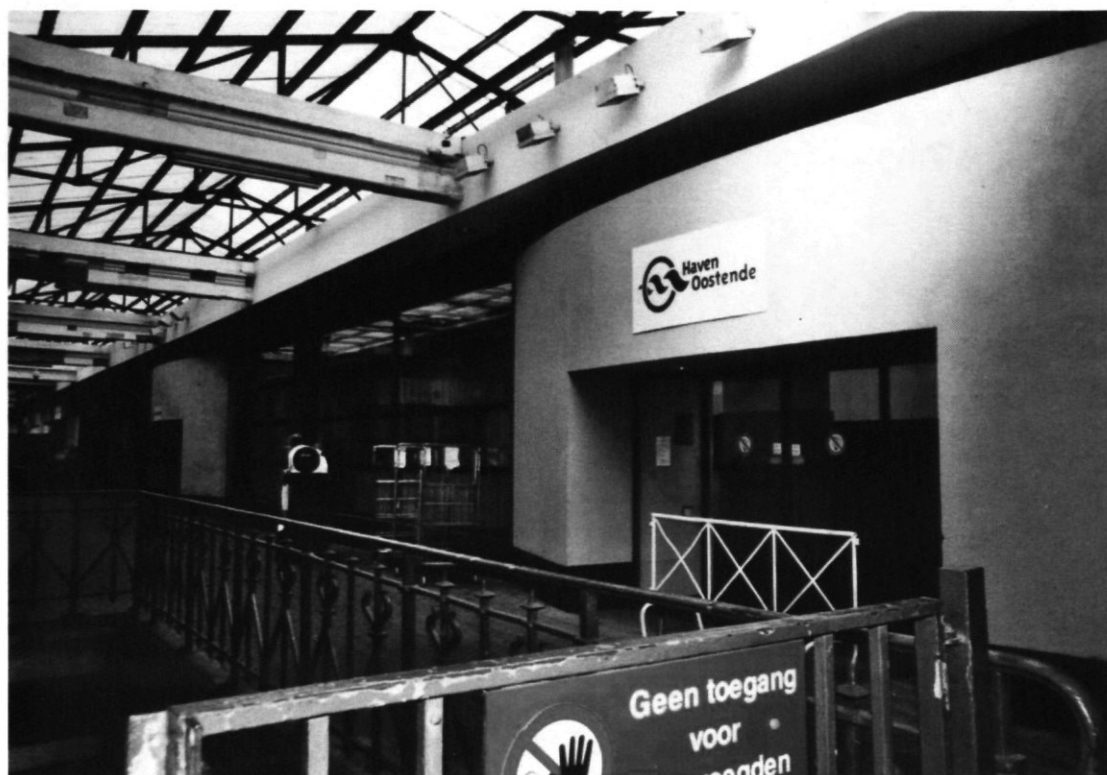
Fig. nr. 254: Haven Oostende, 2012. De in 2012 gesloopte 'cruiseterminal' in het zeestation, toenmalig 'jetfoilterminal' en douanezaal en wachtzaal van de pakketboten.
