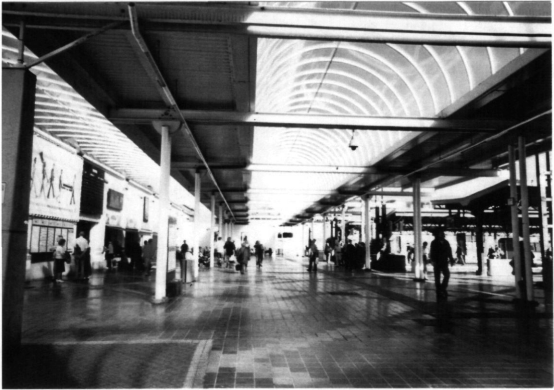
Fig. nr. 256: Haven Oostende, 2012, Zicht op de in 2012 gesloopte 'kop' van de perrons in het zee-station 'Oostende-kaai.
