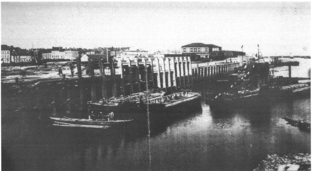
Fig. nr. 167. Haven Oostende, Pakketbotenkaai 1903. Zicht op de Pakketboten in 1904. De sloop van de Franse sluis is voltooid, het baggeren van de resten van de sluis is in de eindfase getreden., Bemerck rechts onder: nog weg te baggeren resten van de sluishoofden. Links: kaaiwerken op post 3 en 4. In de achtergrond het zeestation met spoorluifel
