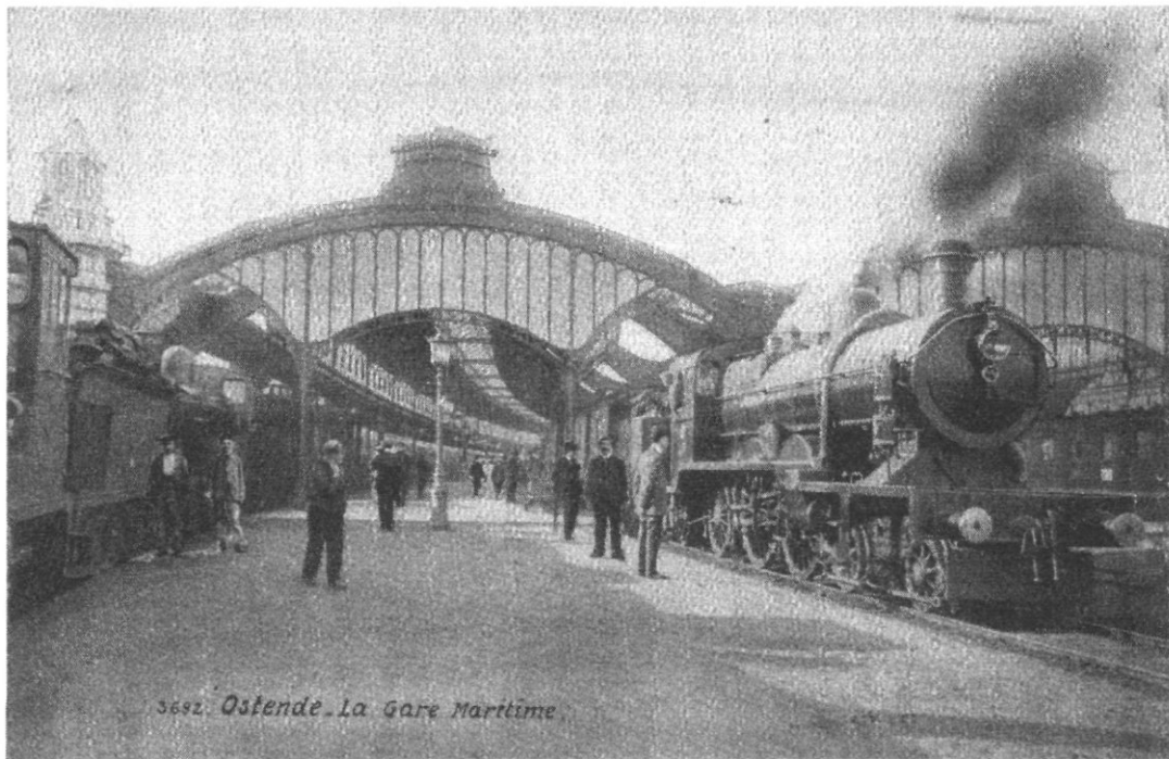
Fig. nr. 170. Haven Oostende, Station Oostende-Kaai, 1913. De spooroverkapping.
