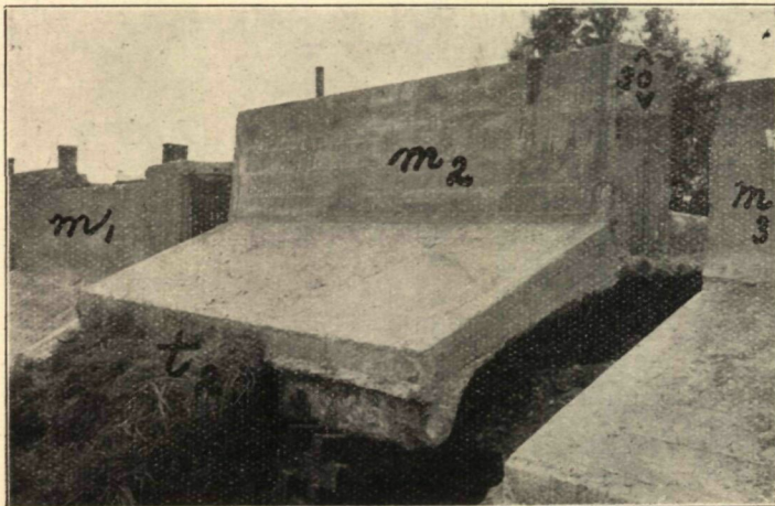
Fig. 15. — Le nouveau talus (extérieur) t en cours de construction.
