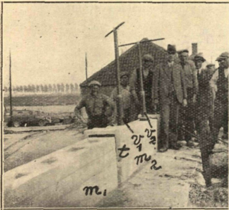
Fig. 10. — Un élément m_2 du parapet levé de quelques centimètres par deux appareils à vis v_1 et v_2 et à nouveau remis droit. Coupe transversale d'un appareil placé dans une cavité.
