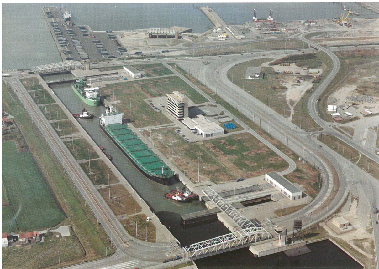
Afb. 5. De Pierre Vandamme sluis (lengte 500 m, breedte 57 m, waterdiepte tot 18,50 m) die schepen tot 150.000 ton kan schutten.
