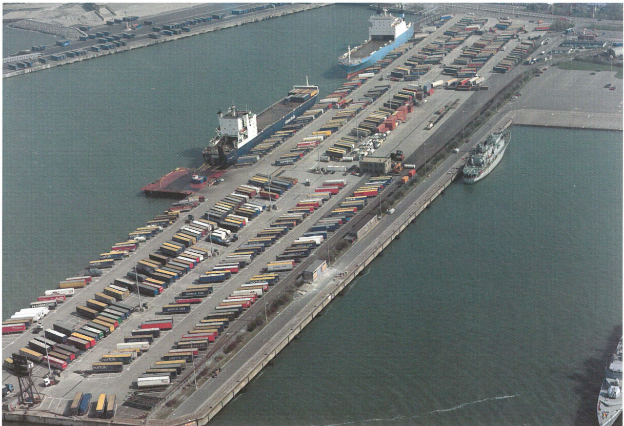
Afb. 7. De Zweedse Kaai ro-ro terminal van SeaRo
