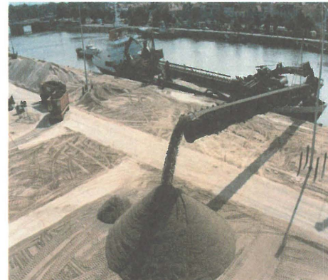
Terug aan land wordt de inhoud van de sleephopperzuiger gelost via een transportband (ZE)
