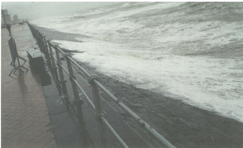
De nood aan algemeen toepasbare regels voor de voorspelling van golfoverslag en de hieraan gekoppelde noodzakelijke kruinhoogte van kustverdedigingsstructuren lag mee aan de basis van het Europese project CLASH. Aan de hand van in-situ metingen (te Zeebrugge, het Italiaanse Ostia en het Britse Samphire Hoe), neuraal-netwerkvoorspellingen en een begroting van de gevaren die met golfoverslag gepaard gaan, leidde dit project tot een inschatting van de schaafeffecten bij schaalproeven en een algemene methode ter bepaling van de optimale kruinhoogte van golfbrekers en dijken (AWW)
