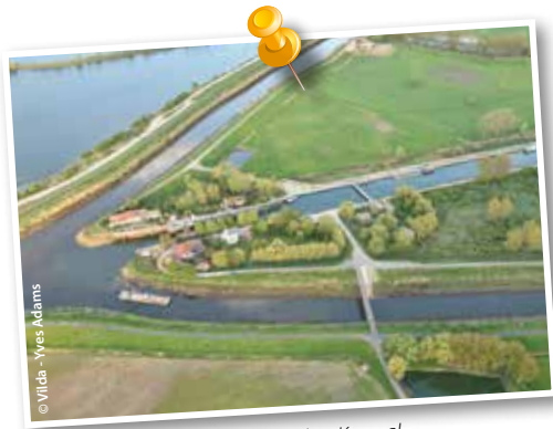
De samenvloeiing van de Dijle, het Kanaal Leuven-Dijle en de Zenne
