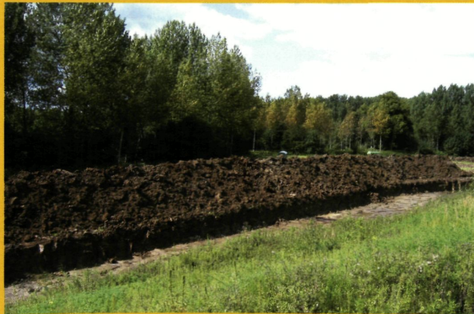
In de Willem-Leopoldpolder komt een tijdelijke grondstockage, zoals hier op de foto bij de aanleg van een overstromingsgebied.
