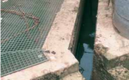
Vertical slot-vispassage en aalgoot Dijke, (Be) Foto: P. Vanhopplinus
