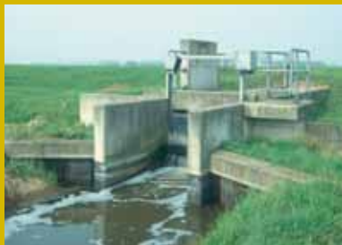
Poldergemaal Hertogswetering (NI). Foto: OVB
