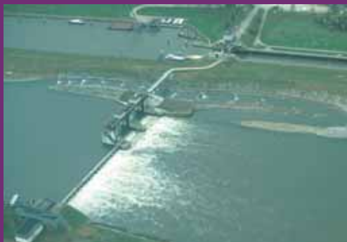
Lokstroom bij een hoge benedenwaterstand, door het knippen van de uitstroom met een strekdam in de Maas bij Roermond (NI)
