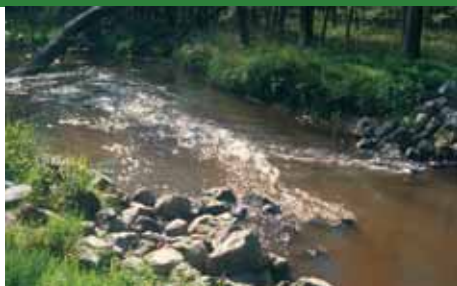
Vvormige drempels stortsteen in Beerze (NI). Foto: OVB
