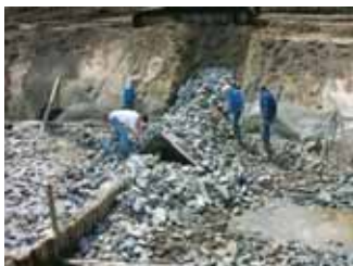
Aanleg van de V-vormige bekkenpassage met vertical slot in de Kleine Nete. De stenen zijn niet overgoten met beton maar in beton geplaatst zodat de ruwheid van de stenen behouden blijft. Foto R.Maes
