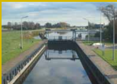
Enkelvoudige schutsluis Schagerkoggen (NI). Foto: OVB
