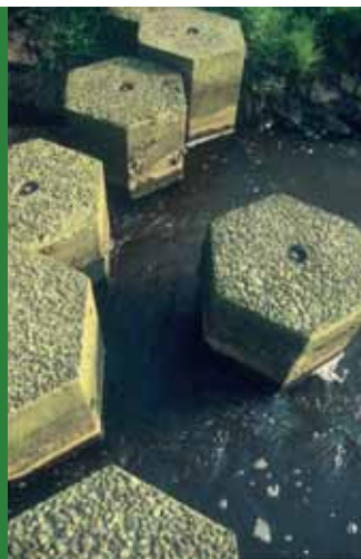
Detailopname van een doorlaat Foto: OVB
