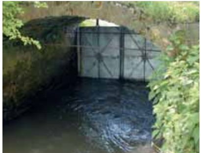
Inlaatconstructie nevengeul Foto: S. Monden
