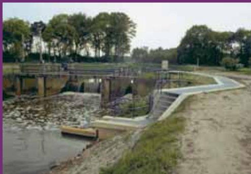
Lokstroom via een geleidewand naar de hoofdstroom gericht, Weerijds (NI) Foto: E. van der Kerff
