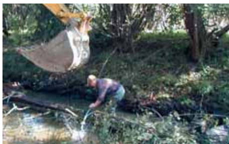
Aanrengen en fixeren van dood hout met wortels in de rivier de Bröl, Duitsland. Foto: G. Mickoleit
