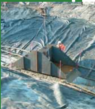
Detailopname van een overlaat (prefab) met sleuf. Foto: C. Dorst
