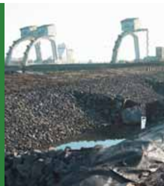
V-vormige bekkenpassage met vertical slot in aanleg. Foto: OVB
