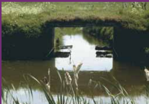
Lokstroom door het knippen van de uitstroom met draadkorven bij Strijbeek (NI) Foto: E. van der Kerff
