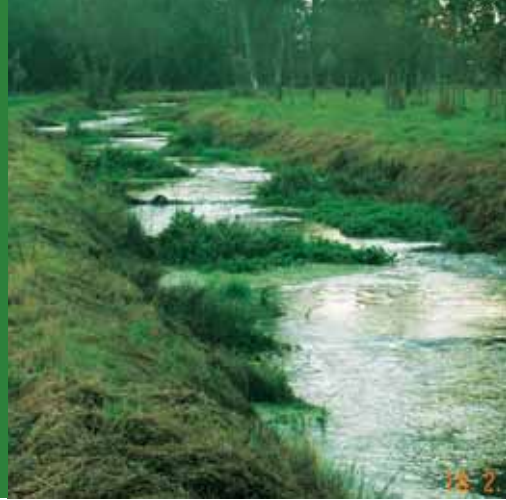
De bekkenpassage met V-vormige overlaten in verdrongen toestand (streaming flow). Foto: T. Gaethofs
