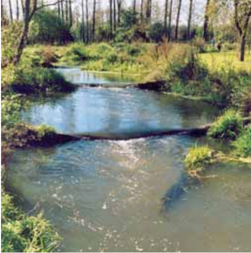
Bekkenpassage met V-vormige overlaten in de Abeek bij normale afvoer (plunging flow). Foto: P. Vanhopplinus
