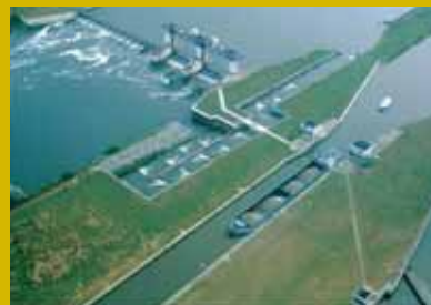
Stuw-schutsluiscomplex Maas, Belfeld (NI). Foto: RWS-Dir. Limburg
