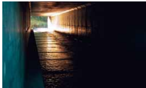
Stroompatroon in duiker na aanleg Foto: B. Iuell
