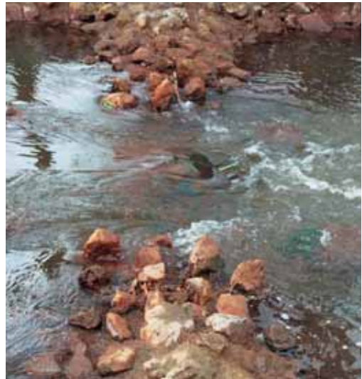
Stoorstenen verlagen de stroomsnelheid, wat de migratie van kleine vissen en kruipende organismen bevordert. De stoorstenen zijn toegepast boven- en benedenstrooms van vertical-slots (hier de visdoorgang in de Tongelreep (NI)). Foto: P. Voorn
