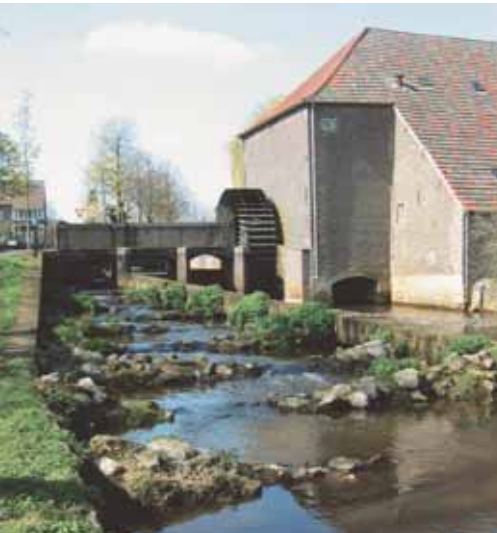
Stroomsnelheden moeten zoveel mogelijk variëren. Bij de Uffelse Beek te Grathem gebeurt dit door het laten verspringen van de V-vorm van de overlaat. Dit resulteert in een diverser stromingspatroon dan bij het standaard ontwerp het geval is (NI). Foto: W. van Emmerik
