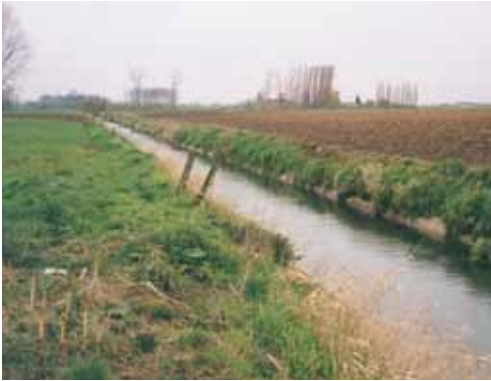
Uniforme, rechtgetrokken waterloop met beperkte ruwheid en weinig variatie ( n = 0,018 - 0,033 )
