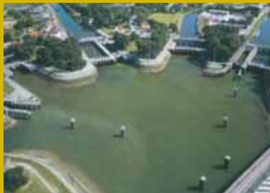
Spuisluizen Ganzepoot, Nieuwpoort (B). Foto: OVB
