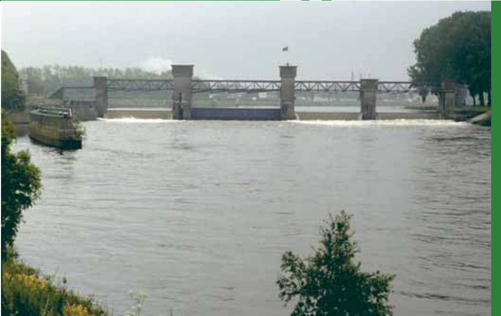
Vooraanzicht stuw en schutsluis (links) Borgharen. Foto: E. van der Kerff
