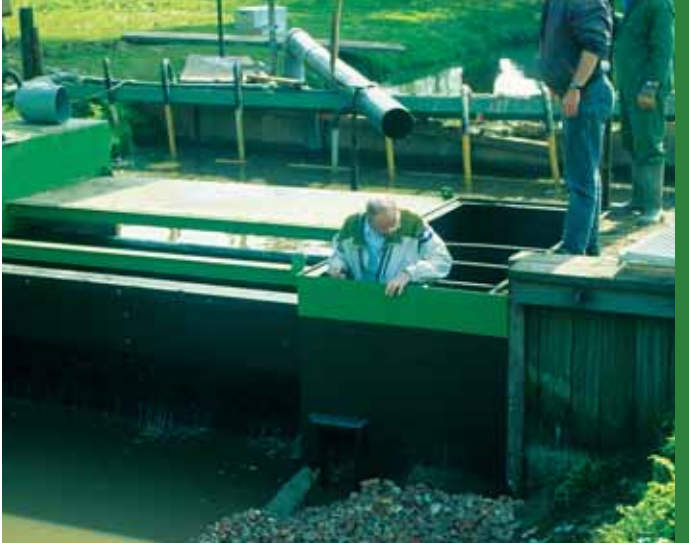
De Wit-vispassage in aanbouw in de Langbroekerwetering Foto: OVB
