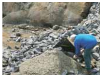
Aanleg van de V-vormige bekkenpassage met vertical slot in de Kleine Nete. De stenen zijn niet overgoten met beton maar in beton geplaatst zodat de ruwheid van de stenen behouden blijft. Foto R.Maes
