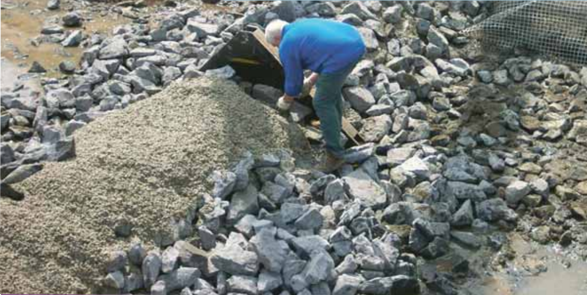
Aanleg van een visdoorgang; de laatste en cruciale fase voor het bereiken van een efficiënte passage.
