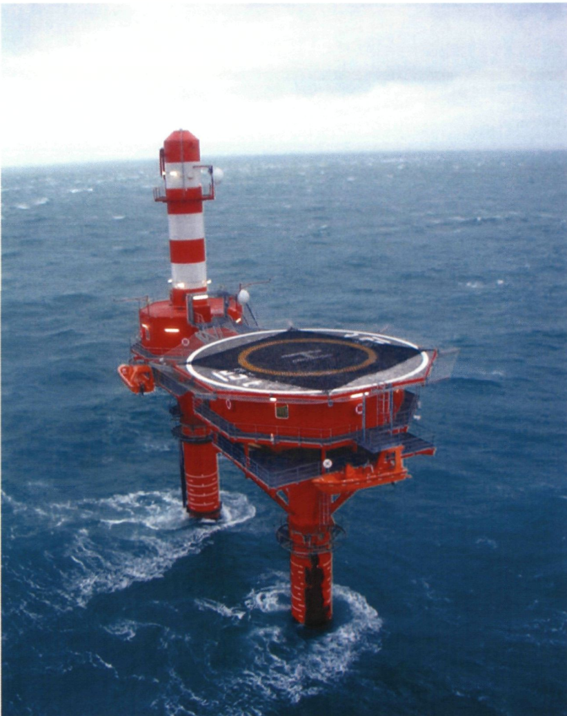
De bouw van de radartoren Oostdyckbank
