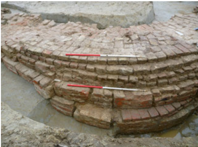
FIG. 8.15 Detailopnames van het gebruik van stukken oud muurwerk in origineel metselverband voor de bouw van de funderingen van de hoektoren (links) en van de westelijke muur (rechts).
