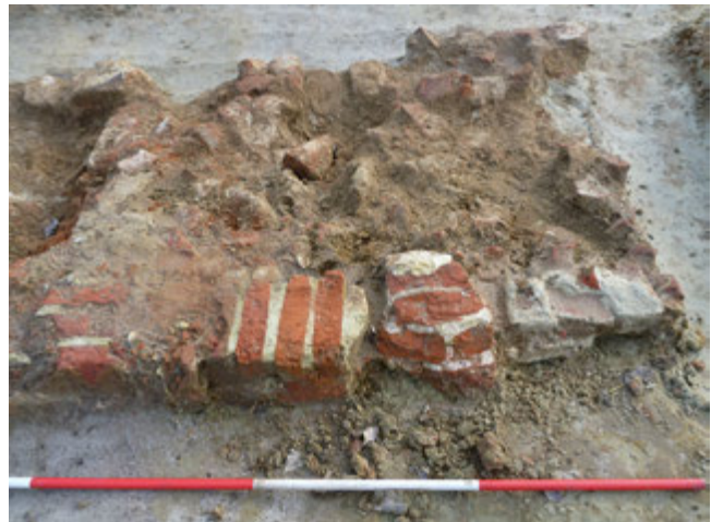
FIG. 8.15 Detailopnames van het gebruik van stukken oud muurwerk in origineel metselverband voor de bouw van de funderingen van de hoektoren (links) en van de westelijke muur (rechts).
