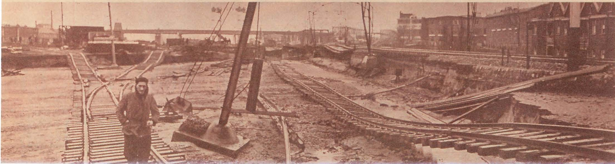
DORDRECHT a particulièrement souffert. La ville, qui compte 70.000 habitants, a dû être partiellement évacuée. Cette vue prise dans le quartier de la gare montre comment l'eau a enlevé toute une étendue de terres. Les voies minées se sont effondrées, tandis que les pylones aux lourds pieds de béton menacent de s'abattre.
