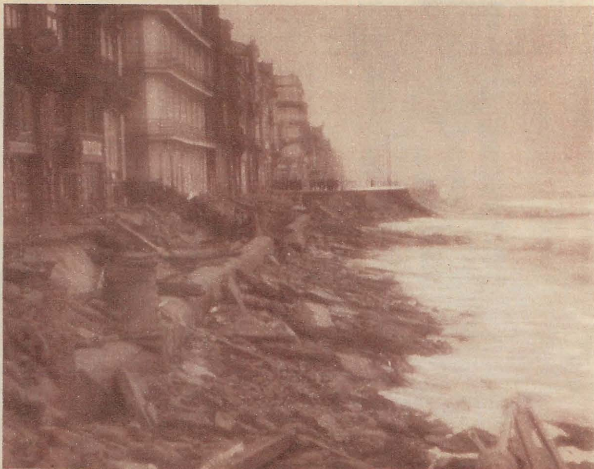
LA PLAGE DE HEYST PENDANT LA TEMPÊTE. — Les masses d'eau jetées contre la digue ont arraché, dans leur reflux, des pavés, des dalles et d'autres objets. Elles ont aussi rompu la digue et l'eau s'est infiltrée au pied des bâtiments.
