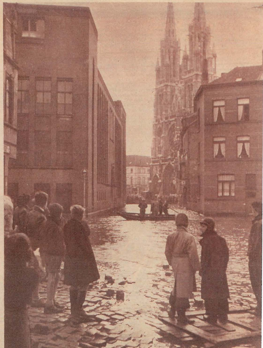
CETTE RUE OSTENDAISE, dominée par la masse imposante de l'église SS. Pierre et Paul, fait penser à un canal de Venise. Mais ici il n'y a pas de gondoles, seulement un canot conduit par des sauveteurs.
