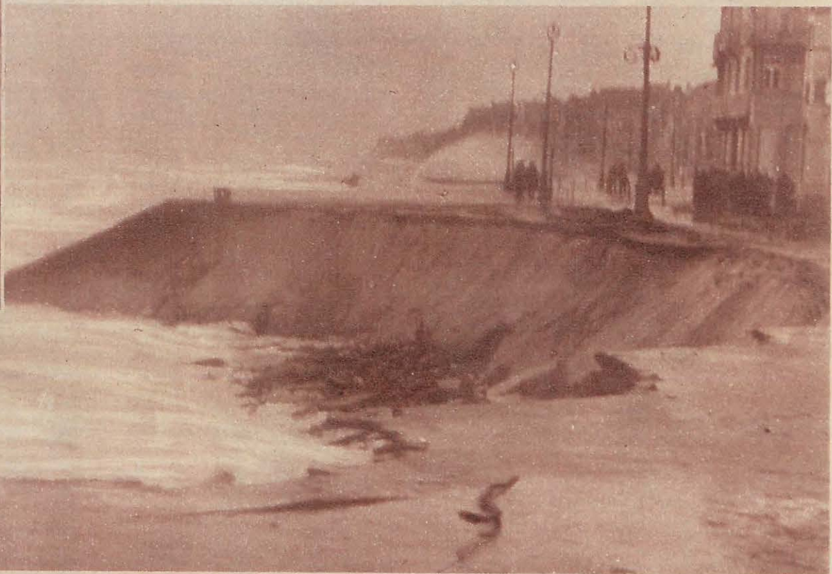
LA PLAGE DE HEYST PENDANT LA TEMPÊTE. — Les masses d'eau jetées contre la digue ont arraché, dans leur reflux, des pavés, des dalles et d'autres objets. Elles ont aussi rompu la digue et l'eau s'est infiltrée au pied des bâtiments.
