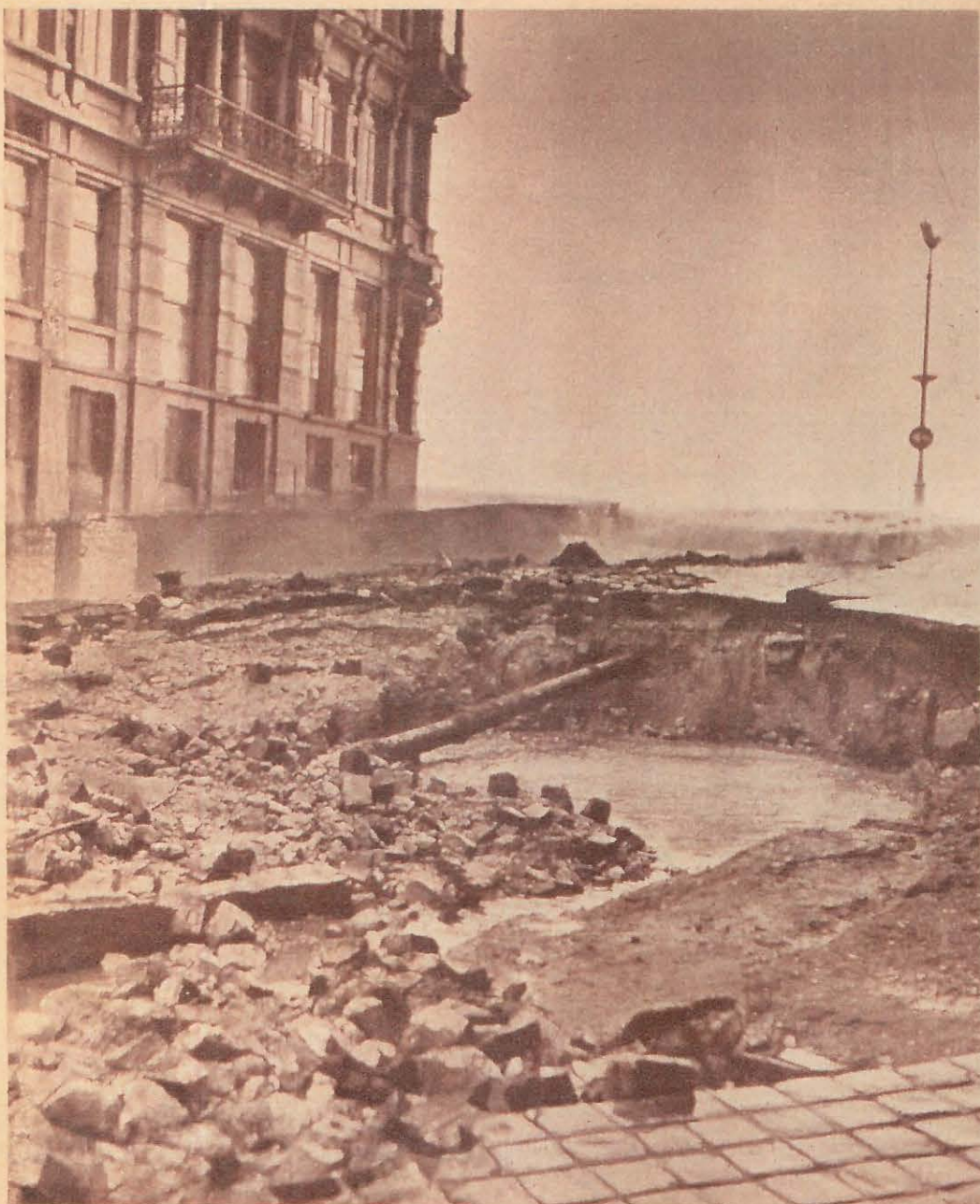
UN ASPECT DE LA RAMPE LOUISE, à Ostende. Le sol s'est profondément affaissé et les fondations des maisons sont en partie dénudées. Dans le fond, on voit une lame qui déferle par-dessus la digue.
