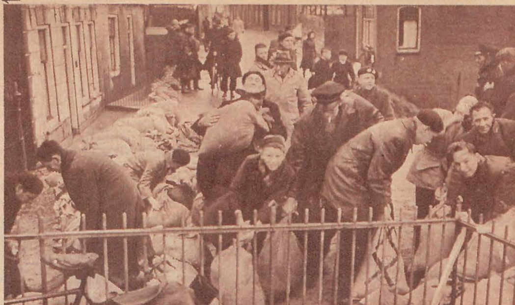
PARTOUT DES VOLONTAIRES se sont présentés pour aider à colmater les brèches ou édifier de nouvelles défenses contre les flots. Ces gens, habitants de Krimpen aan den Yssel, disposent des sacs de sable et de terre derrière une grille.
