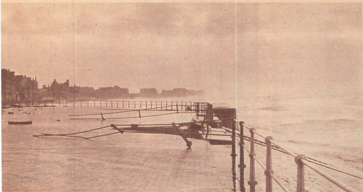
LA DIGUE-PROMENADE d'Ostende, en face du nouveau Kursaal, a elle aussi été endommagée. Le garde-fou a été arraché et l'eau a descellé d'énormes blocs de pierres bleues. On aperçoit à gauche d'autres débris. Derrière ceux-ci, on distingue l'ancienne villa royale.
