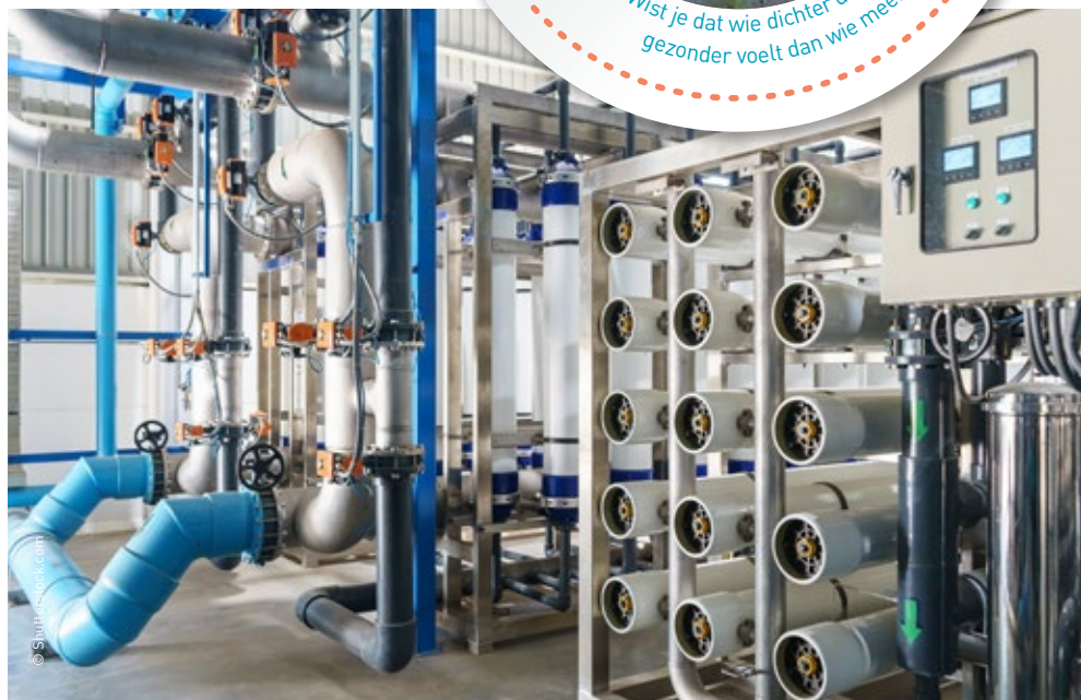
Een ontziltingsinstallatie die het principe van omgekeerde osmose toepast.
