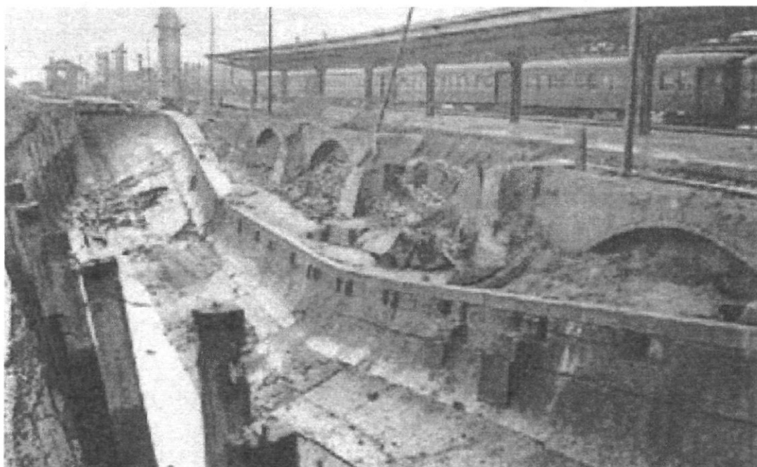
Fig. nr. 188. Haven Oostende; 1935. Zicht op de instorting van de Pakketbotenkaai t.h.v. aanlegposten 3/4. Achtergrond het onbruikbaar spoor 1 van het spoorwegstation Oostende-Kaai. Op spoor 2 een reizigerstrein bestaande uit een stel "Voiture Métallique à bogies, type 1932" Van deze moderne rijtuigen werden er 410 geleverd aan de N.M.B.S.
