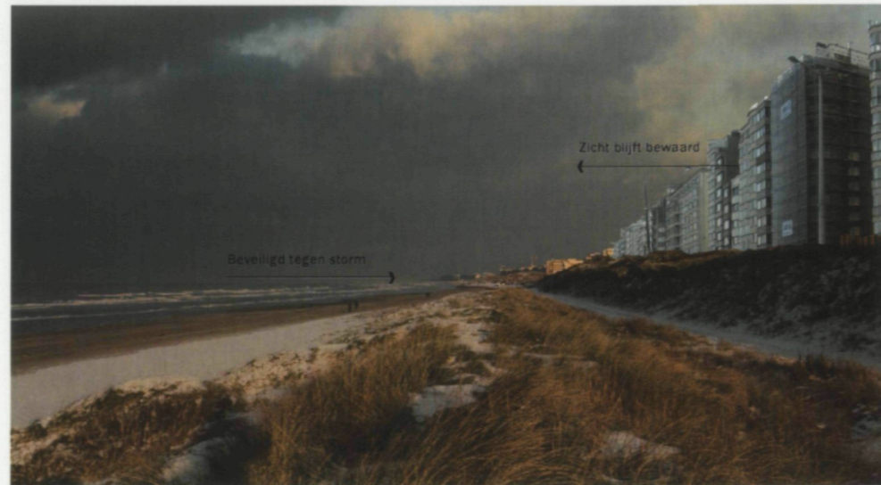
Een lage duin voor de Vlaamse dijk geeft nog steeds een zicht van de dijk naar de kust, maar beveiligd de dijk wel tegen stormen.
