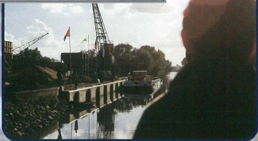
De kaaimuur langs de Dender van het bedrijf De Witte Gebroeders te Herdersem bij de inhuldiging op 6 mei 2000
