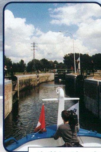
Als "kleiner" kanaal ontsnapt het Kanaal Leuven-Dijle niet aan de aandacht van de NVZ. Terwijl werd verder gewerkt aan het Strategisch Beleidsplan Kanaal Leuven Dijle, zette NVZ het renovatieprogramma der sluizen verder. Hier de heropening van de gerenoveerde sluis van Kampenhout op 29 mei 2000
