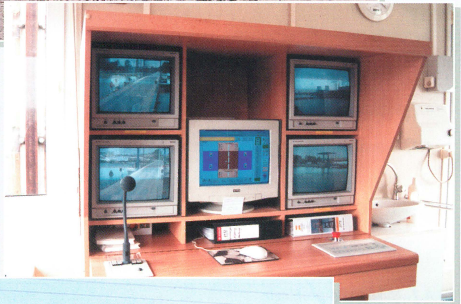
De bedieningspost van de Willemsbrug, op de Verbrande Brug te Grimbergen
