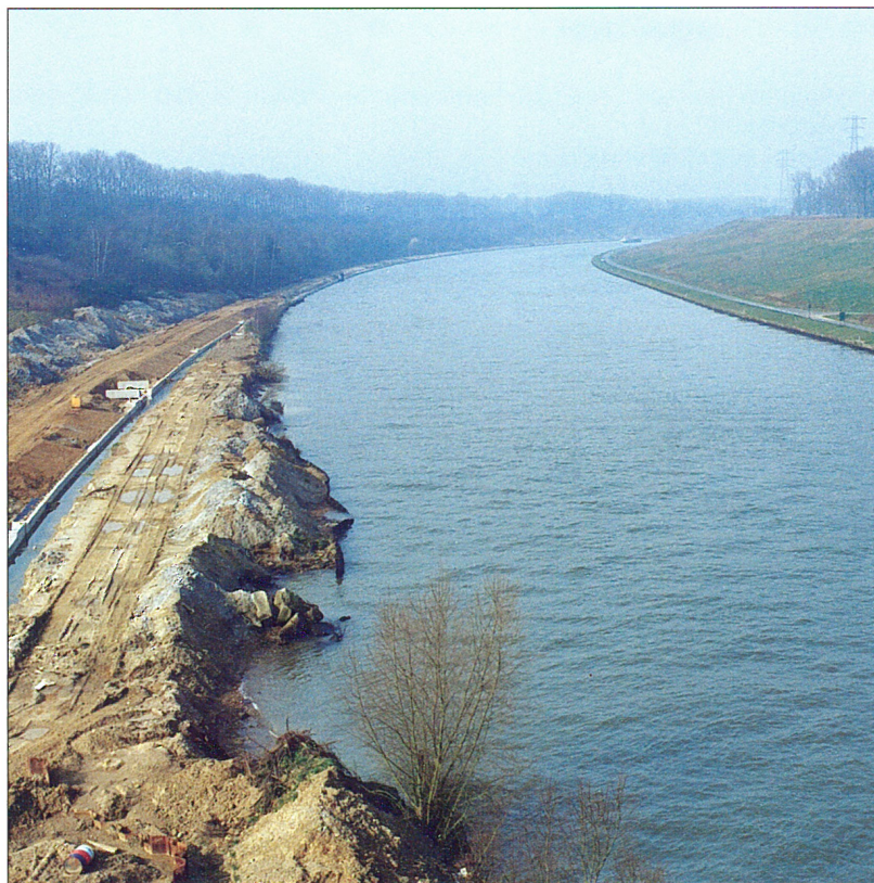
Verbreedingswerken van het Albertkanaal in het vak Eigenbilzen-Gellik
