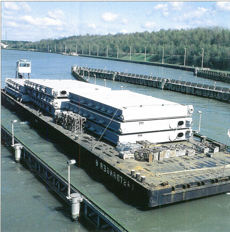
Lossen van sluisdeuren te Ham en Olen
