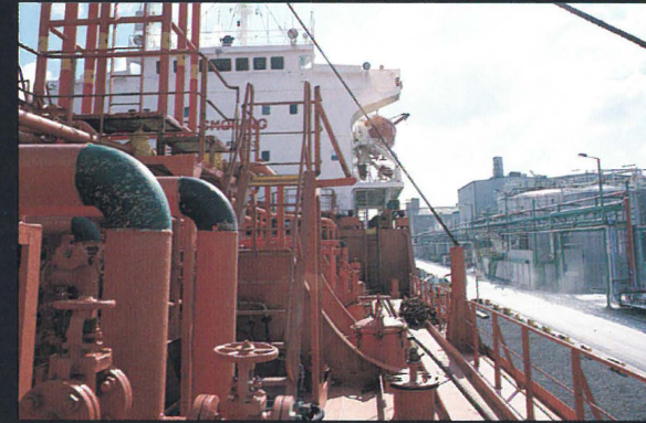
In 2003 werd nagenoeg iedere maand een nieuwe kaaimuur in gebruik genomen.
