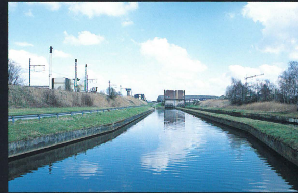
Pompstation te Ruisbroek. De waterwegen spelen behalve een economische, onder meer ook een waterbeheersende rol.
