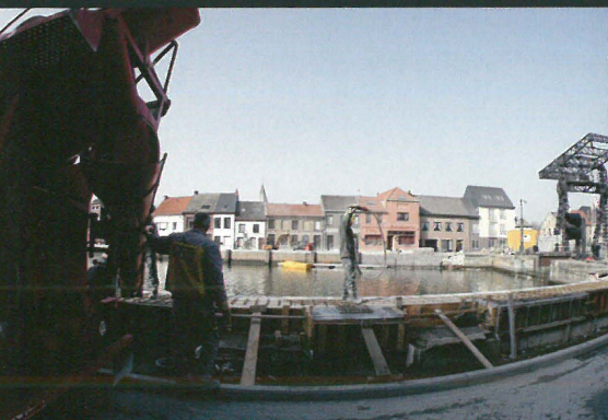
Bouw van de kanaaloevers te Klein-Willebroek. Bouwen aan een kanaalomgeving waarin het goed om leven is, hoort tot de hoofdbekommernissen van de NV Zeekanaal.
