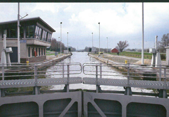
Bouw van Lembeek op het Kanaal naar Charleroi. In 2003 werd verder geïnvesteerd in de reiniging en heraanleg van de omgeving van bruggen en sluizen.
