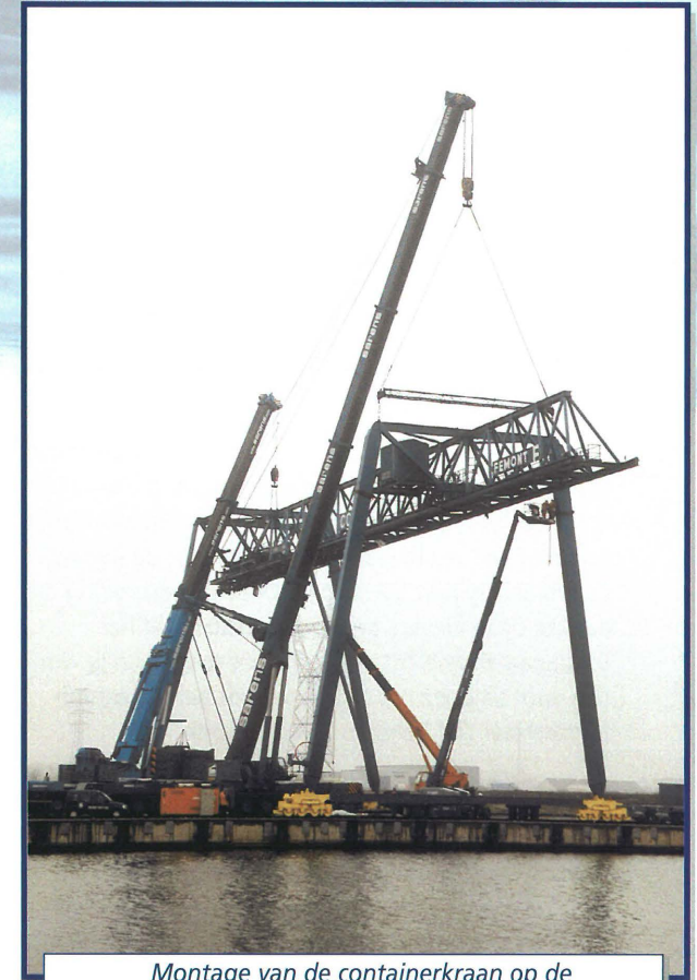
Montage van de containerkraan op de Cargovil Containerterminal (CCT) te Grimbergen
