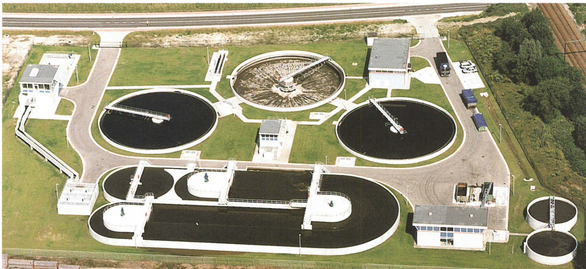
Zuiveringsinstallatie Boom-Niel, ingehuldigd op 26-9-1997
