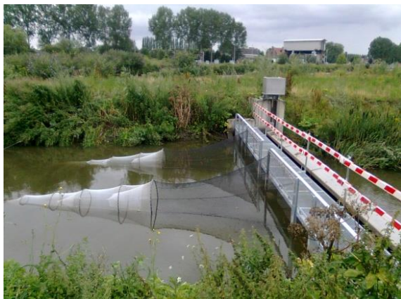
Figuur 7: De fuikconstructie die de gehele breedte van de nevengeul overspant.
