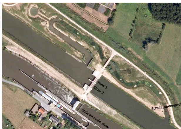
Figuur 5: Het Scheldewater kan aan de sluisstuw van Asper op 5 locaties stroomafwaarts vloeien: ter hoogte van twee stuwen, de sluis en de oude stuw en via de schuif van de nevengeul.
