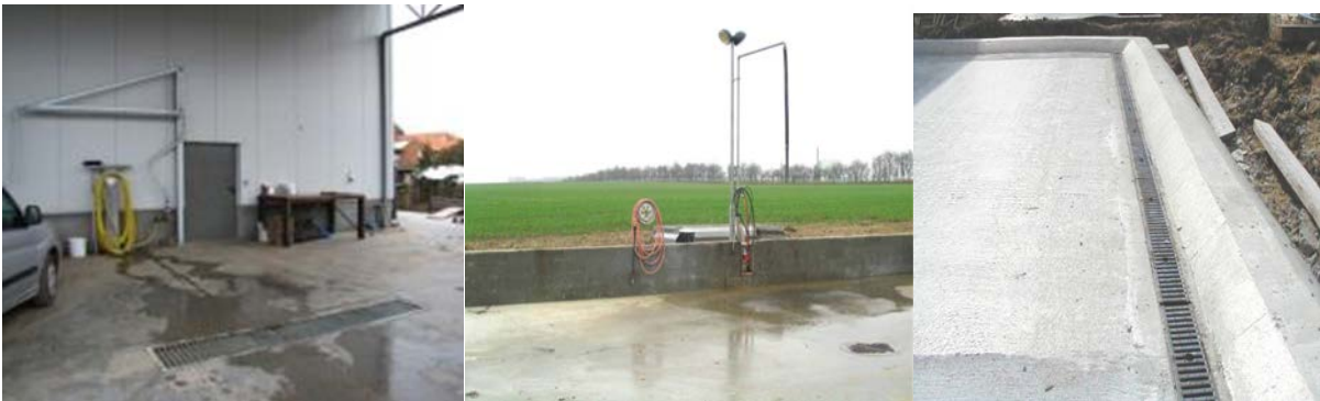
Afbeelding 50: Vul- en wasplaats : galgsysteem voor het vullen van een spuittoestel (bron : Inagro)
